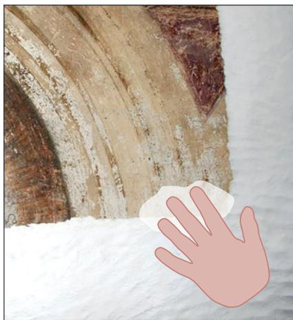
Gráfico 6: aquí se aplican compresas manualmente sobre los frescos deteriorados por la sal.
