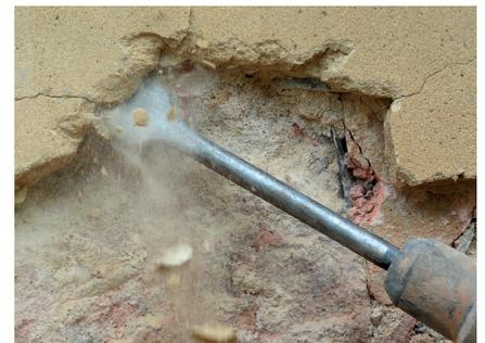
Foto 3: retirada del enfoscado antiguo para el secado completo de la pared
