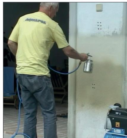
Foto 3: la eliminación de la sal mediante maquinaria en grandes superficies de enfoscado.
