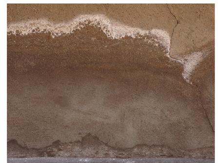
transportándolos a la superficie del enfoscado. Generalmente, a menudo es suficiente con retirar 0,5 m por encima de la zona de evaporación superior ②, medida con el método de alta frecuencia, y en 100 m lineales de saneamiento del enfoscado se ahorran 50 m<sup>2</sup> de renovación de enfoscado, lo cual supone una gran cantidad de dinero.
