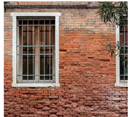
Foto 2: a pesar de haber picado la pared, la humedad persiste y, en algunas partes, hasta se aprecia de forma visible.
