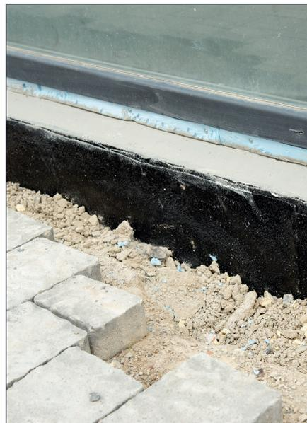
La renovación de un aislante contra la humedad vertical en la mampostería exterior del sótano es extremadamente compleja.
